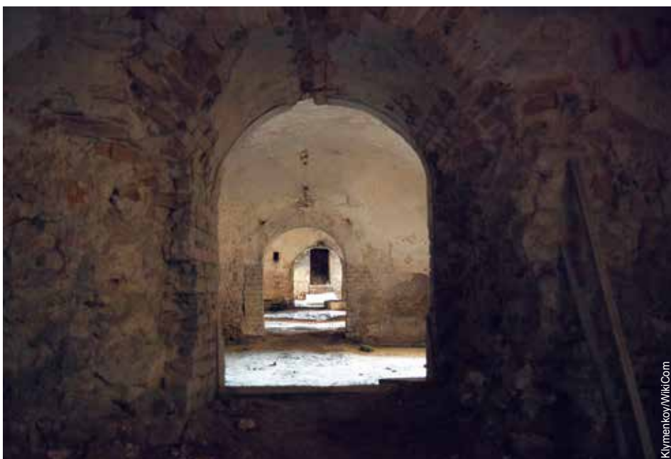
Wszystkie skrzydła zamku są podpiwniczone. Zachowały się po dziś dzień, wymagają jednak solidnej renowacji.
