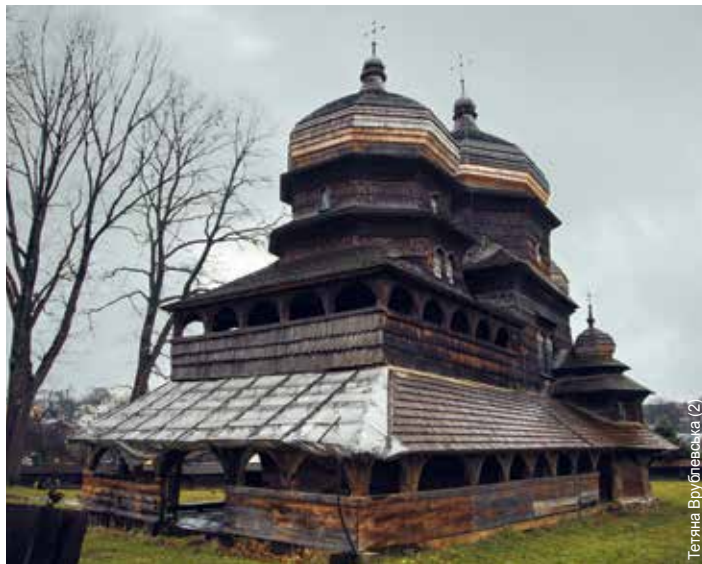
Współczesny widok cerkwi św. Jerzego w Drohobyczu w trakcie prowadzonych prac konserwatorskich Сучасний вигляд церкви св. Присяжні у Дрогобичі під час консерваційних робіт
