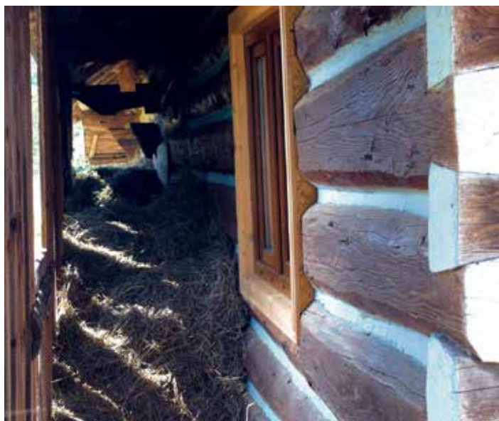
Wzdłuż jednej ze ścian biegnie tzw. zachata, czyli korytarz oddzielający ściankę z desek od właściwej ściany chaty / Уздовж однієї зі стін проходить так звана захата, або коридор, що відокремлює приміщення за допомогою стіни, складеної з дощок, від зовнішньої стіни хати
